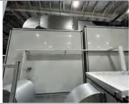
三级过滤+二级活性炭（用于处理自动化喷漆线废气）
