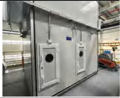
三级过滤+二级活性炭吸附（用于处理手动喷漆线废气）
