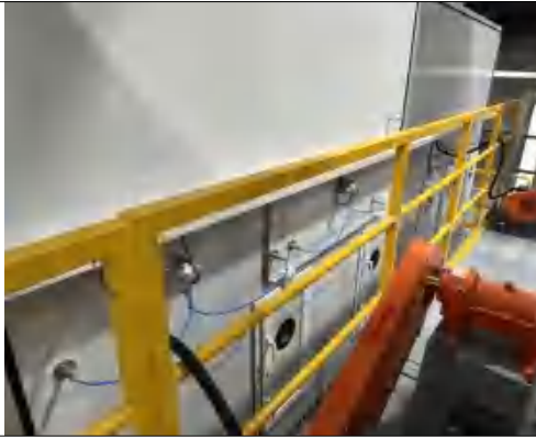
三级过滤+二级活性炭（用于处理自动化喷漆线废气）
