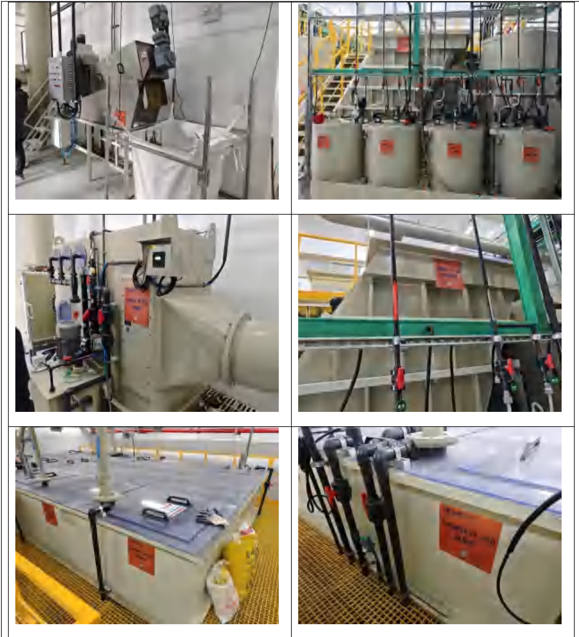
图 3-2 厂区污水站内污水处理装置
