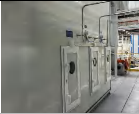
三级过滤+二级活性炭吸附（用于处理手动喷漆线废气）
