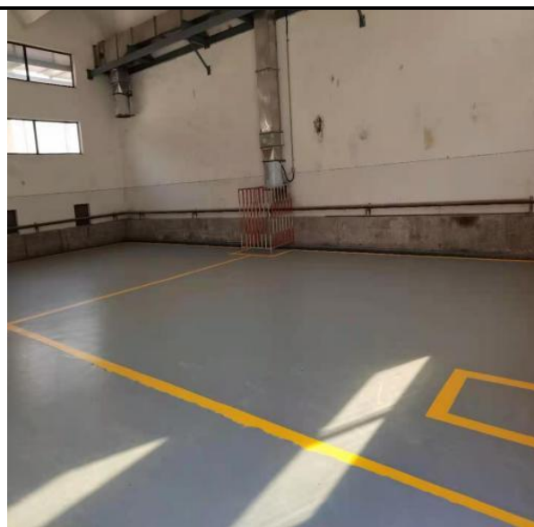
防腐防渗地坪
