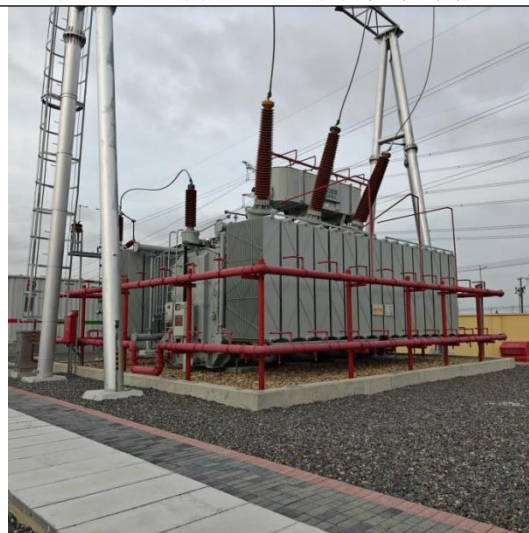
图 6-19 主变接地、降噪
