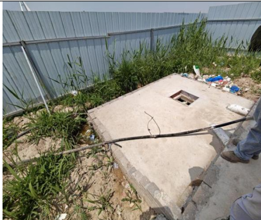
图 6-2 施工营地化粪池
