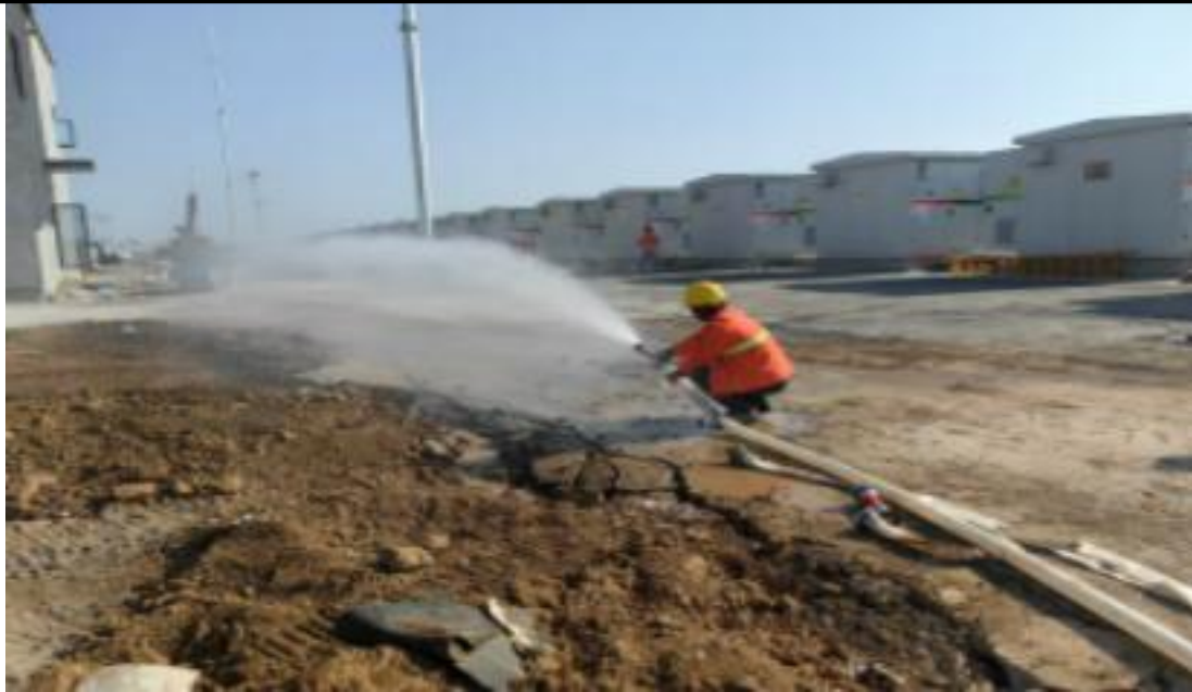
图 6-1 施工场地洒水
