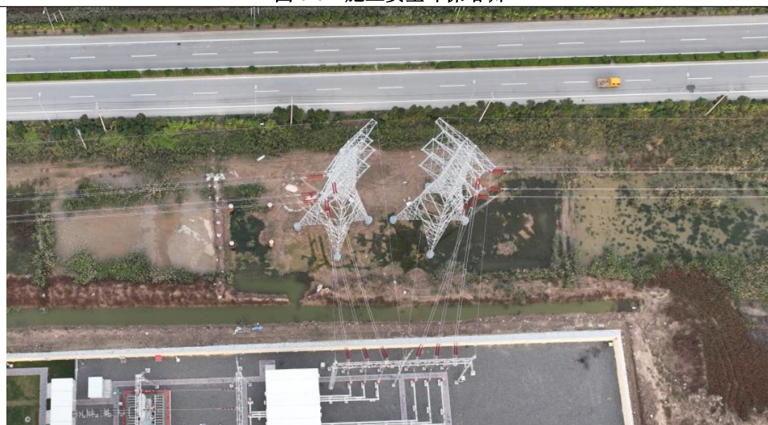
图 6-7 新立塔基周围土地及拆除杆塔的塔基混凝土基础恢复原有土地使用功能 本项目运行期环境保护措施落实现场照片：
