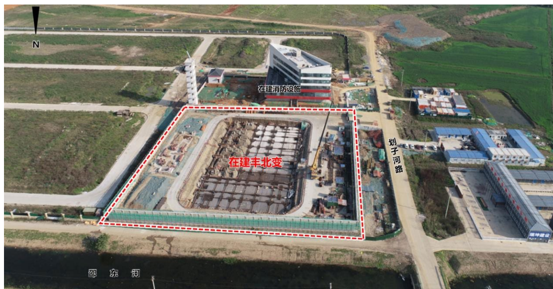
图 3.1 丰北变施工照片
