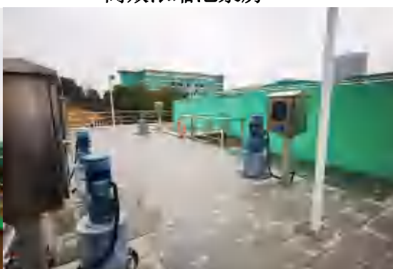
浓缩池顶部照片（封闭式）
