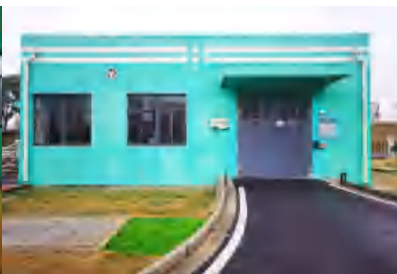
高效浓缩池泵房
