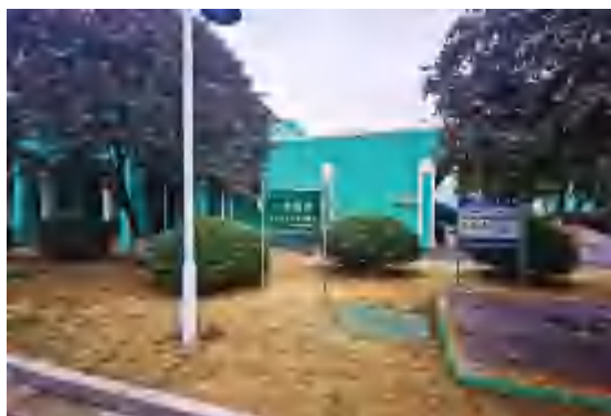
现有普通快滤池（编号一期滤池）
