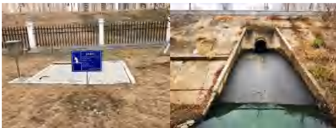
雨水排口标示牌
