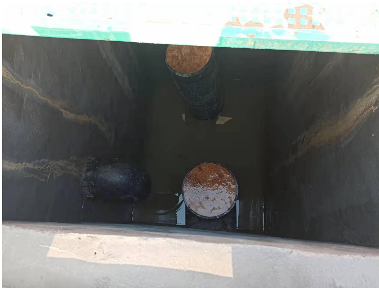
隔油池、切换阀、水封井现场照片
